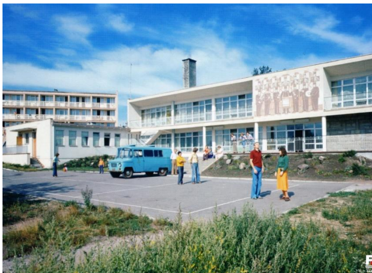
Ośrodek wypoczynkowy „Eden”, dawny hotel „Górnik” przy ul. Rybackiej 159 w Katakach Rybackich z dekoracją elewacji frontowej w formie sgraffito
