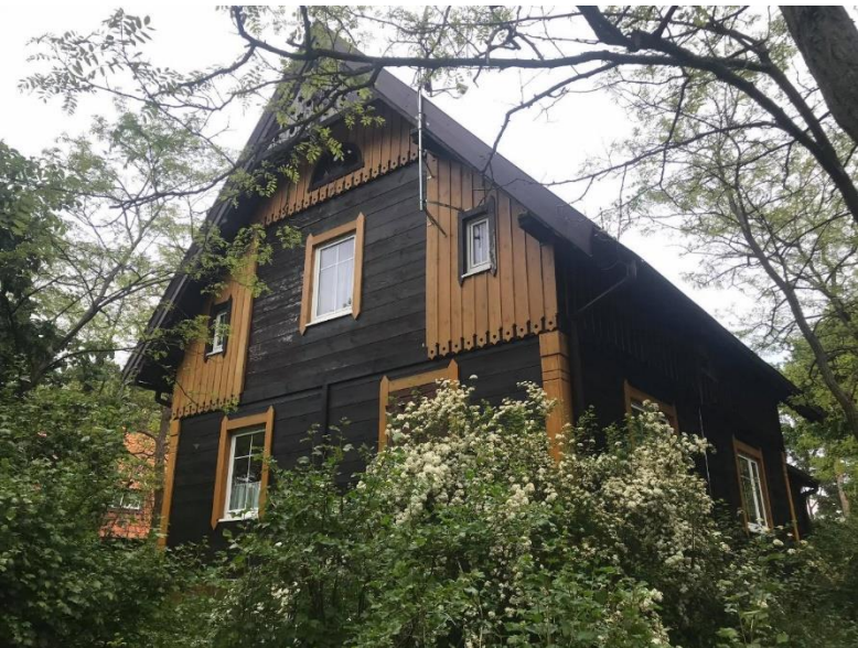
Budynek mieszkalny d. sezonowy dom letniskowy, Krynica Morska, ul. Teleekspru 5
