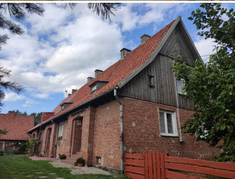
Siedlisko, budynek mieszkalny i gospodarczy, Krynica Morska – Przebrno, ul. Wiejska 2
